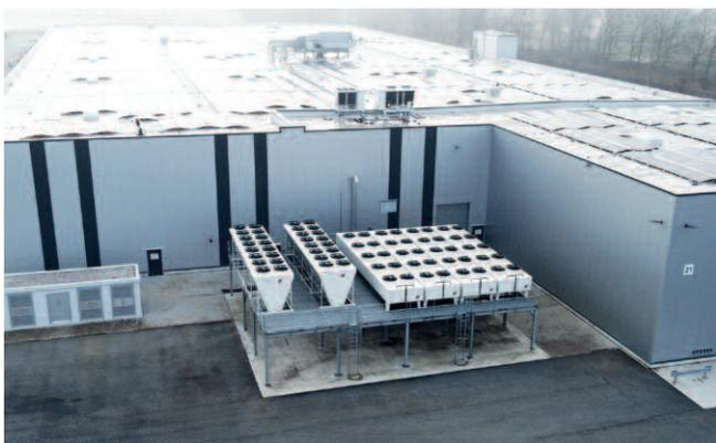
**Bild 4:** Die Kondensatoren für die Abführung der Abwärme wurden platzsparend auf einer Bühne montiert (© L&R Kältetechnik)
