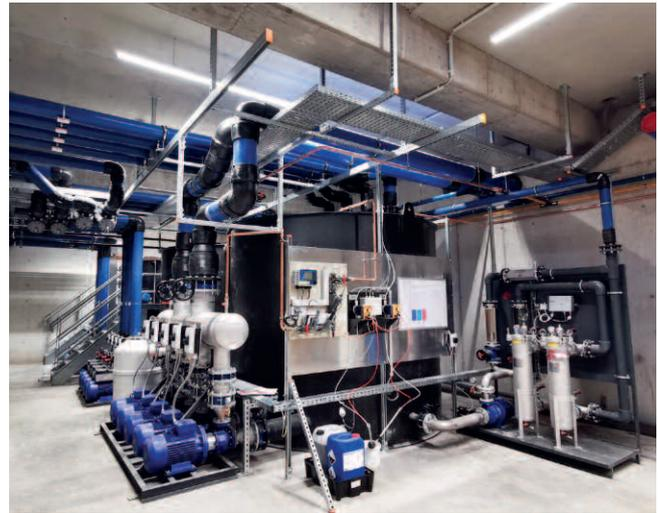
**Bild 3: Üblich bei der Kälteversorgung von Extrusionsanlagen: die Pumpen-Tank-Kombination im Keller (© L&R Kältetechnik)**
